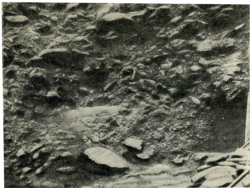
Рис. 42. Золотоносный пласт, покрытый валунной глиной; борт старого разреза Успенского прииска. Справа видна стойка в устье орта, служившего для добычи пласта в борту россыпи
