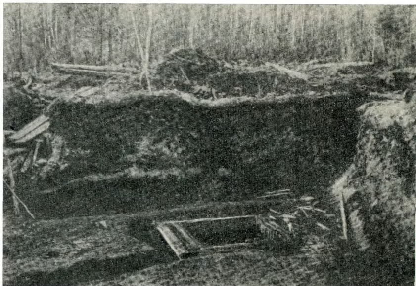
Рис. 32. Шурф с забивной крепью, вскрывший главную струю Ямаровского минерального источника во время разведочных работ в 1896 г.
